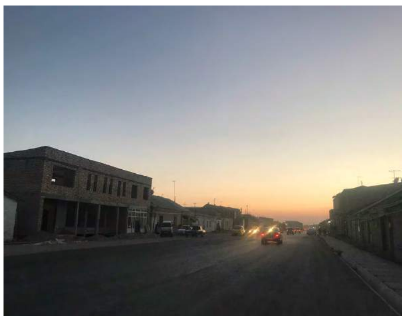
新しい道を作るために取り壊しが進んでいる古い町並み：ブハラ
